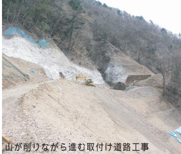
山が削りながら進む取付け道路工事
